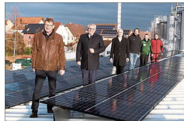
Ein wichtiger Schritt für die »nachhaltige Zukunft« des Hochdorfer Unternehmens wurde getätigt: Geschäftsführer Eberhard Haizmann (von links), Jörg Stahl und Günther Röhm von der Bürgerenergie, die beiden Braumeister Moritz Krahl und Marcel Schmid sowie PV-Techniker Philipp Katz nach der Fertigstellung der Anlage. Foto: Reimer
